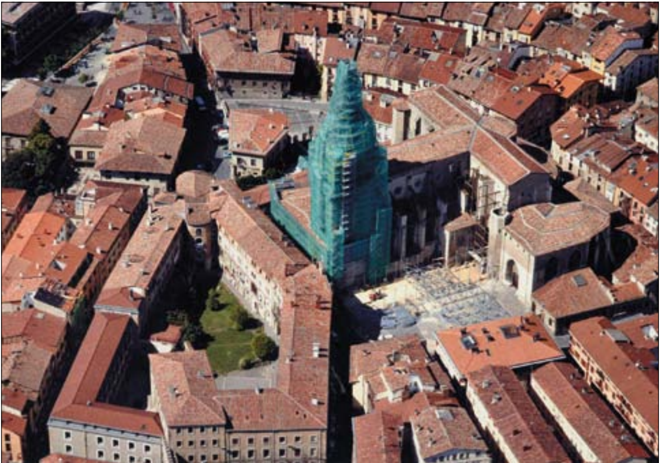
Figura 5.1. Vista aérea de la catedral de Santa María durante el proceso de restauración (Foto Fundación Catedral Santa María).
