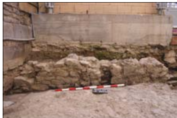
Figura 5.30. Detalle de uno de los nuevos medianiles levantados en el edificio.
