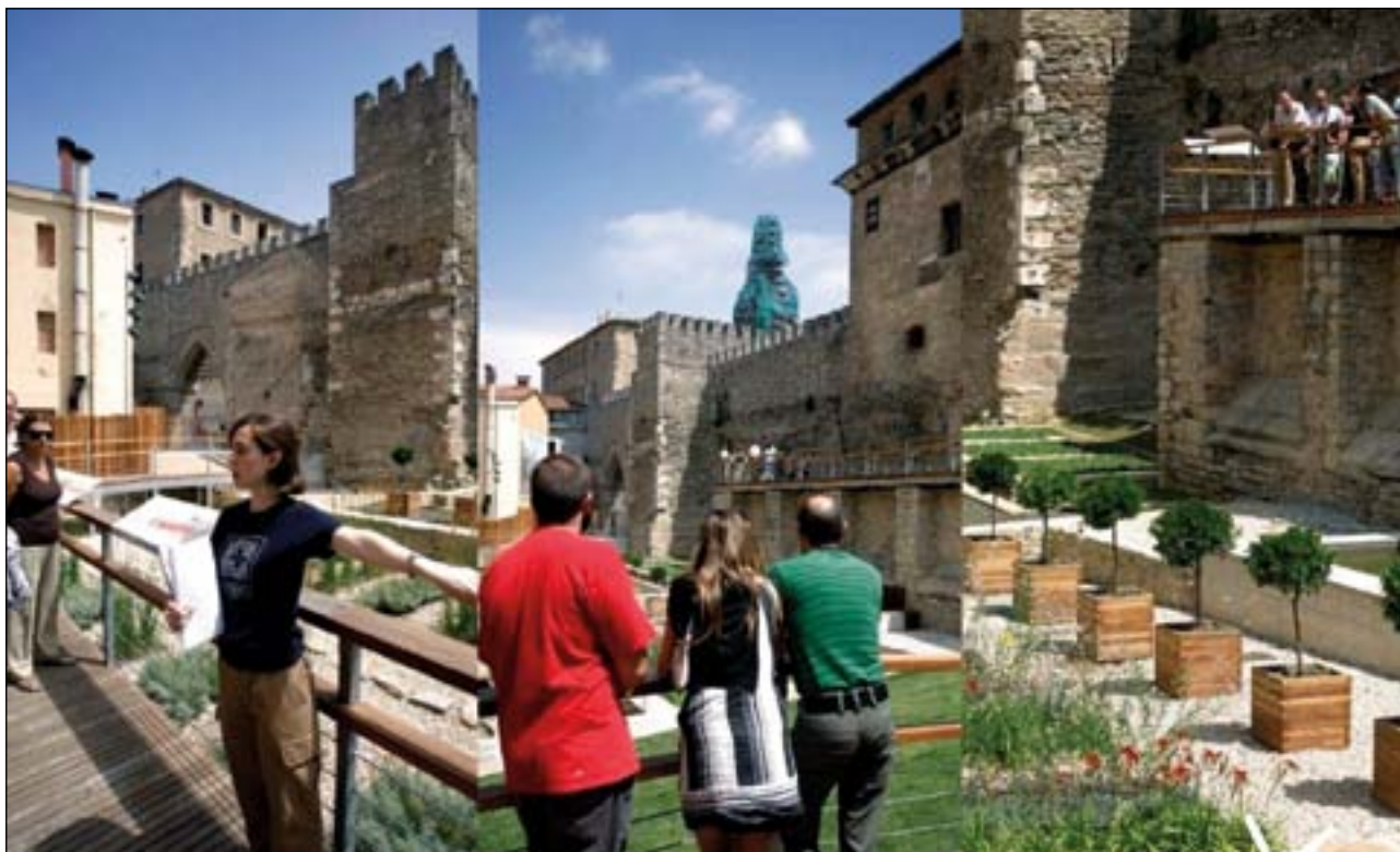
Figura 3.1. Proyecto de recuperación de las murallas realizado en las traseras del palacio Escoriaza-Esquivel.
