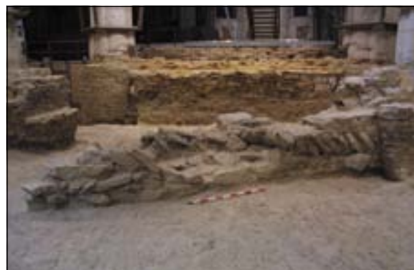
Figura 5.26. Detalle de la cimentación de la muralla localizada al interior de la catedral.
