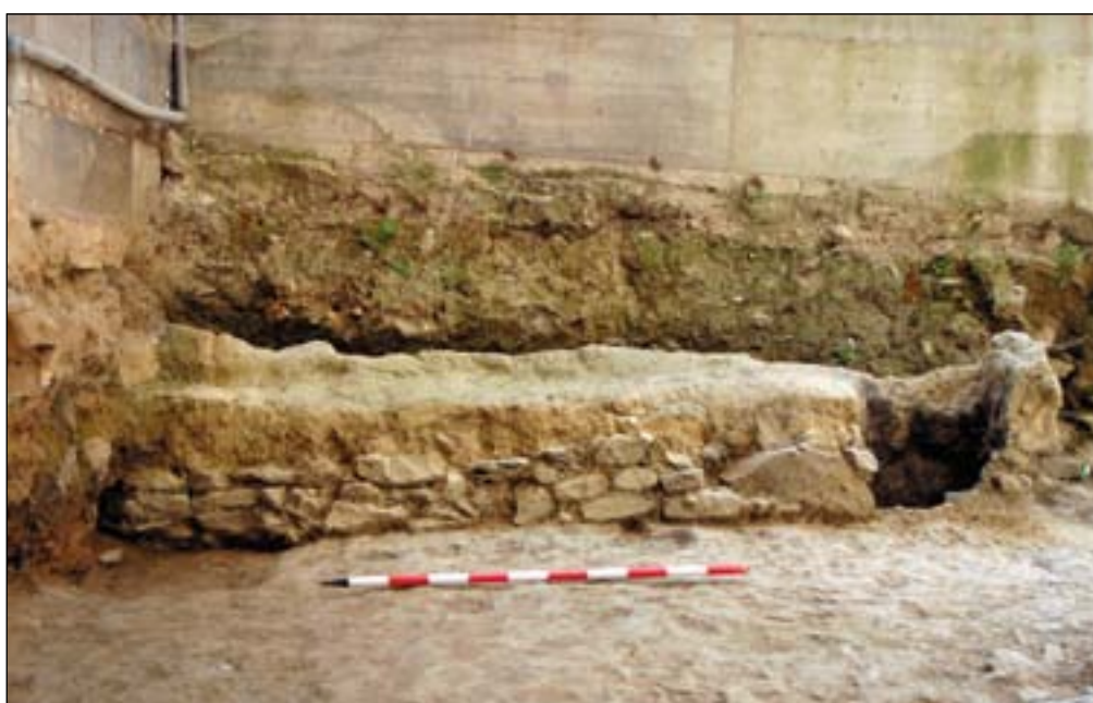
Figura 6.97. Restos conservados de façonnage direct sobre zócalo de piedra.
