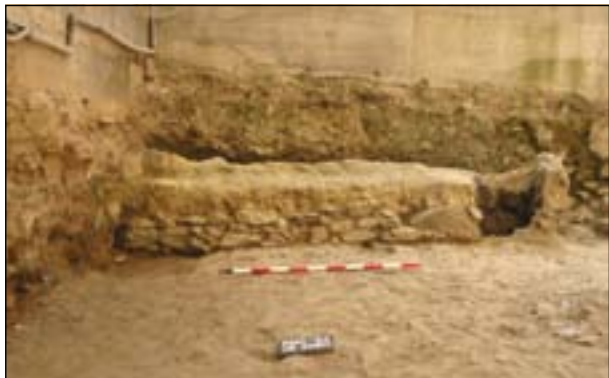
Figura 5.18. Detalle de uno de los medianiles levantados en el edificio.
