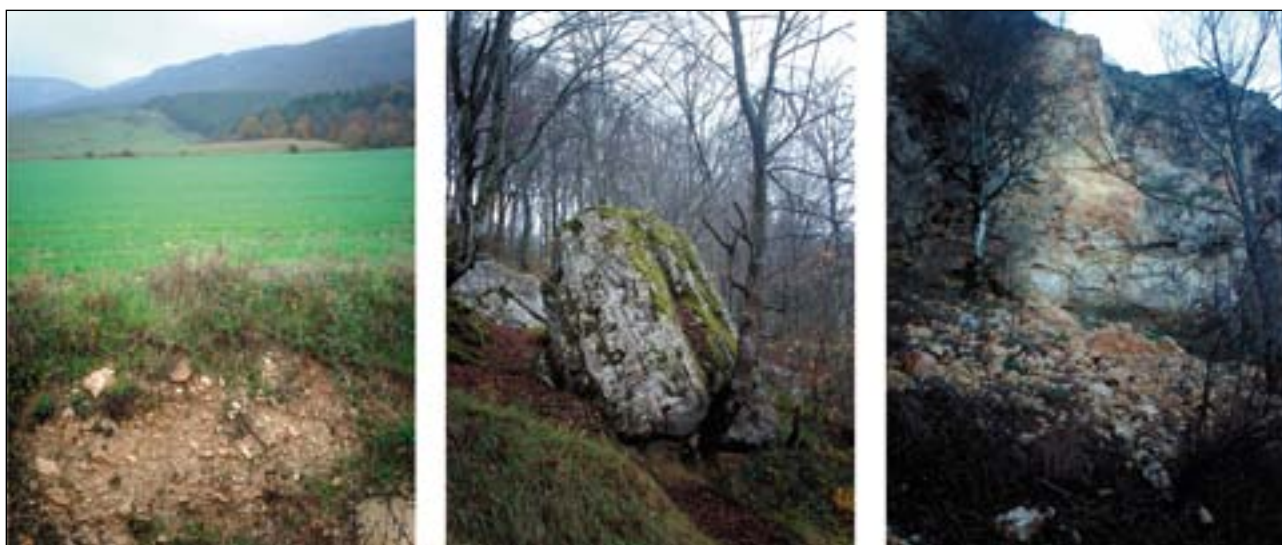
Figura 2.4. Fotografías con varios ejemplos de algunos de los procesos que se dan en la Llanada: A izquierda imagen de las importantes graveras que tapizan las laderas; en el centro y a al derecha ejemplos de caída de bloques y desprendimientos.
