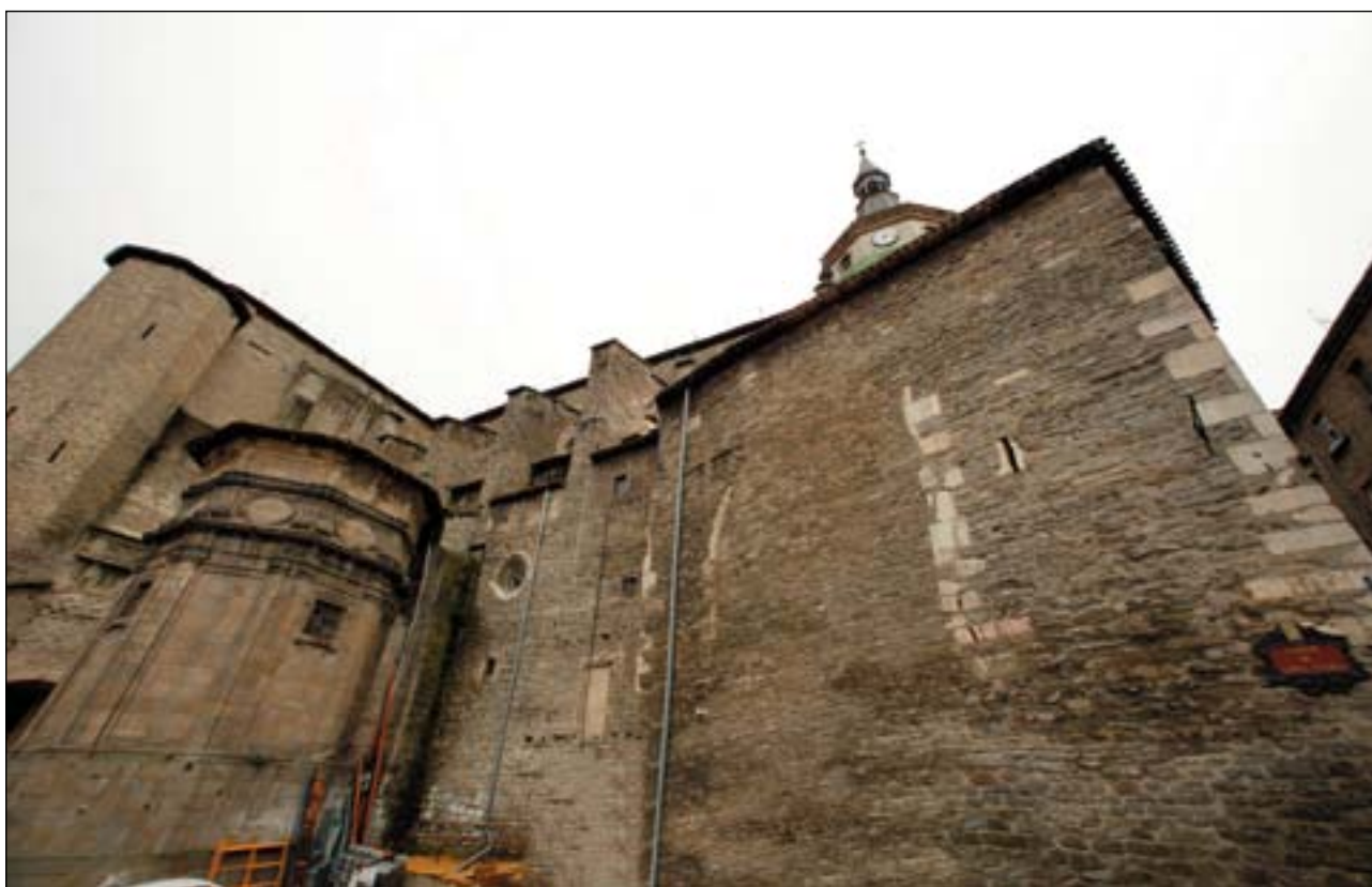
Figura 5.28. Torreón conservado en el extremo noroeste de la catedral, envuelto por la obra del pórtico.
