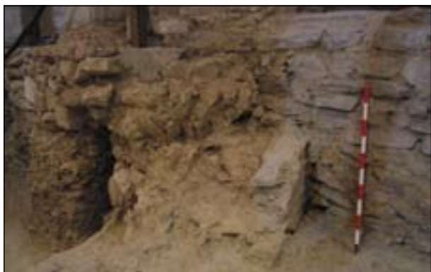
Figura 5.34. Detalle del muro de doble hoja con núcleo a sacco localizado en la zona del testero curvo.
