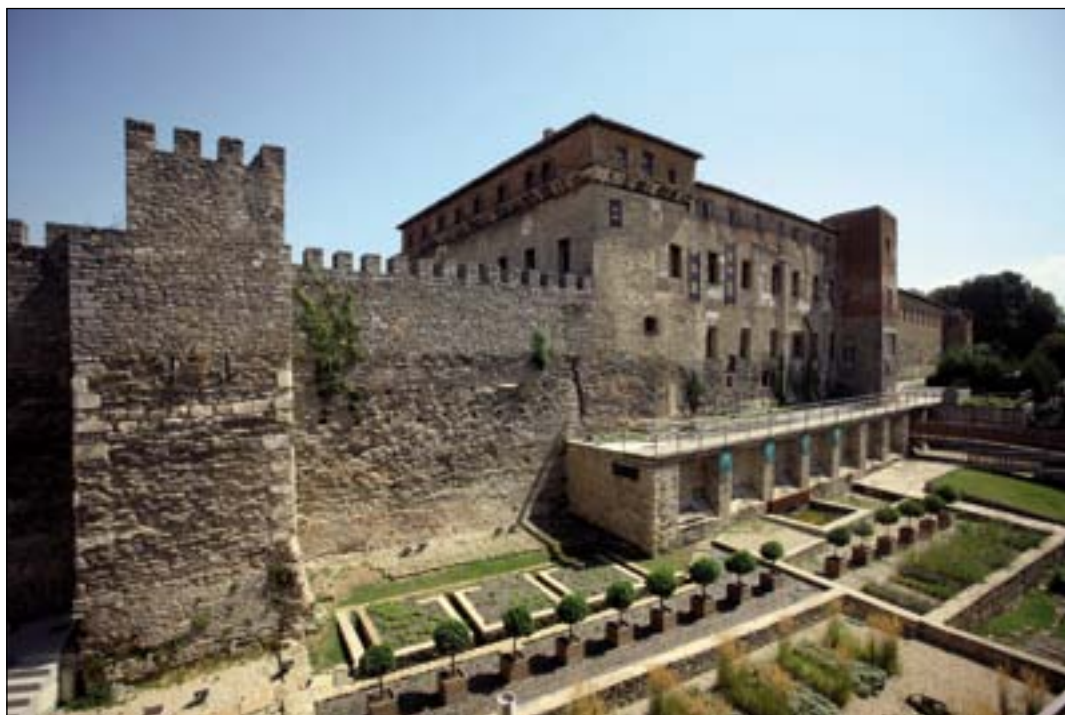
Figura 7.42. Imagen de la muralla en las traseras del palacio Eskorriaza-Eskibel, con las torres 8 (derecha) y 9 (izquierda).
