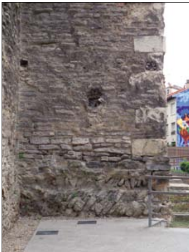
Figura 7.35. Cimentación y alzado documentado en uno de los torreones que recorren la muralla.
