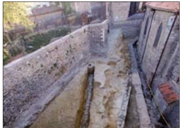
Figura 7.38. Vista del torreón 3 y del lienzo de muralla intervenido en las traseras de la iglesia de San Miguel.
